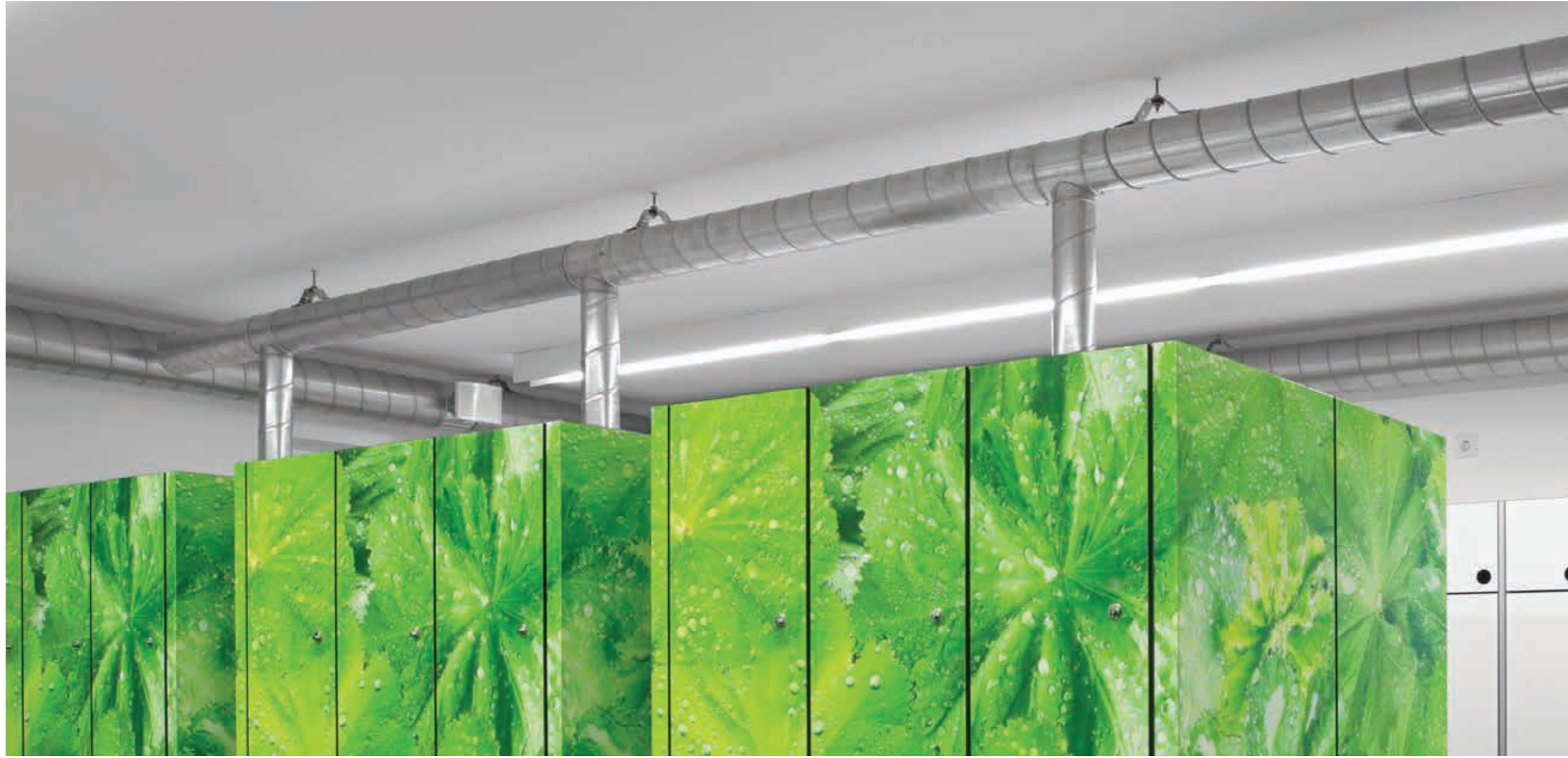
Zwangsbelüftung durch Anschluss an bauseitige Abluftanlage
